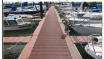
Bootsstegbelag aus TRIMAX
