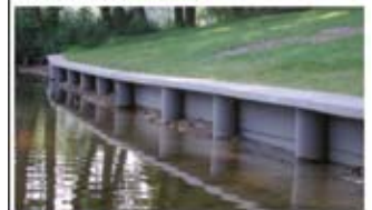
TRIMAX als Uferbefestigung
