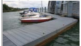
Bootsstegbelag aus TRIMAX
