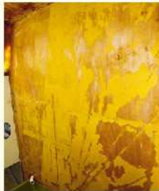
▲ Nach dem Abziehen der alten Verkleidung verbleiben noch sehr viel Schaumstoff und Kleber, die mühsam entfernt werden müssen
