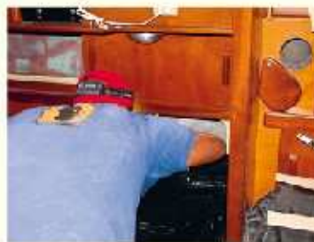
▲ Nach dem Abziehen der alten Verkleidung verbleiben noch sehr viel Schaumstoff und Kleber, die mühsam entfernt werden müssen
